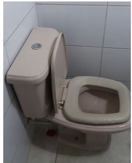
Vaso sanitário – caixa acoplada com duas vazões de válvula
