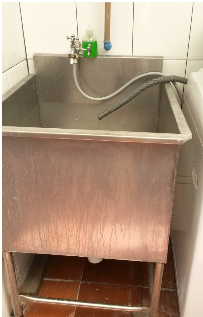
Aproveitamento da água da máquina de lavar – para piso
