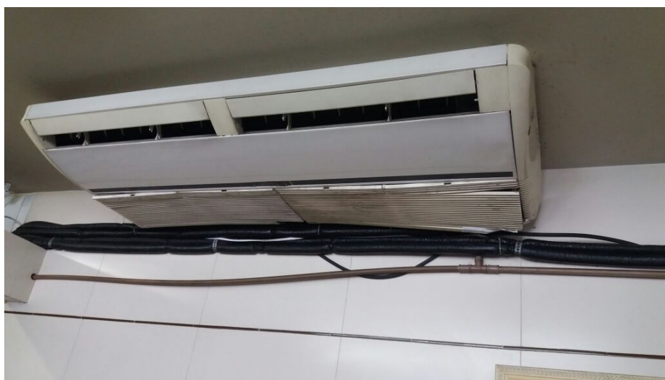
Ar condicionado – Tubulação em cano PVC para coleta de água
